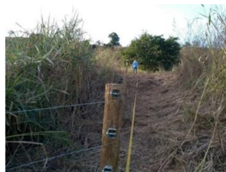
São Vitor/MG Verificação de cerca concluída
