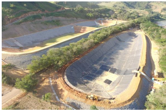
Bacia 01: Instalação de geomembrana – junho/2018 (Crédito: Divulgação Fundação Renova)
