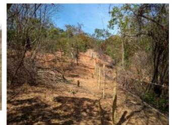
Galiléia/MG Verificação de cerca concluída
