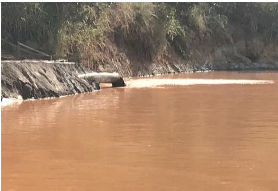
Setor 5: Dragagem de sedimentos – junho/2018 (Crédito: Divulgação Fundação Renova)
