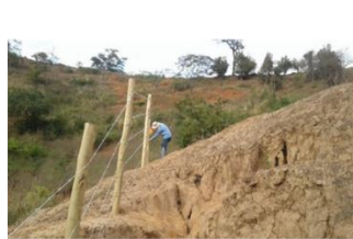
São Vitor/MG Verificação de cerca concluída
