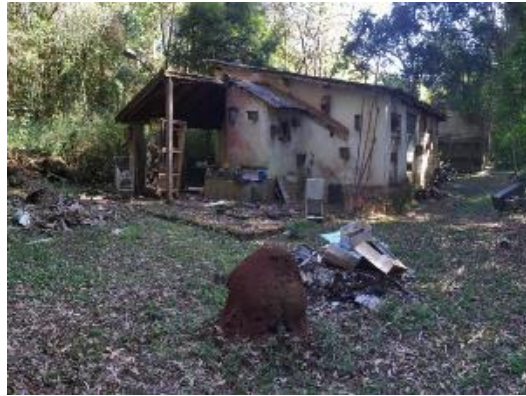
Visita ao local de construção do CETAS-MG – junho/2018
