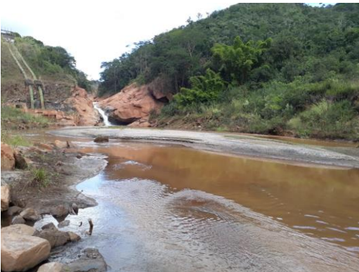
Acompanhamento da vistoria da Ramboll no trecho 8 do Plano de Manejo de Rejeitos – Junho/2018 (Crédito: Divulgação Fundação Renova)
