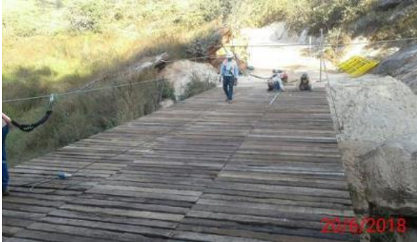
Reforma da Ponte Camargo x Bento em andamento – junho/2018 (Crédito: Divulgação Fundação Renova)
