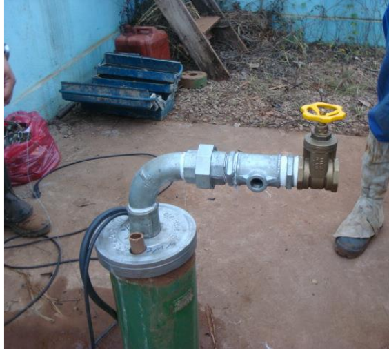
Novo conjunto de bomba submersa em Barra Longa – Gesteira – Junho/2018 (Crédito: Divulgação Fundação Renova)
