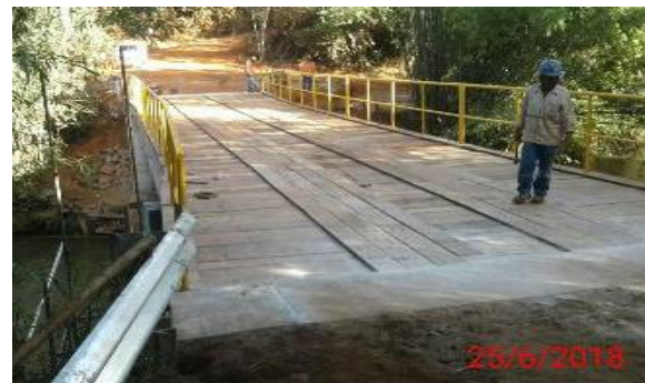
Reforma da Ponte Mariana x Bento em andamento – junho/2018 (Crédito: Divulgação Fundação Renova)
