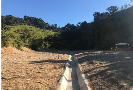
Descomissionamento do setor 5B Fazenda Floresta (próximo à configuração final) – maio/2018 (Crédito: Divulgação Fundação Renova)
