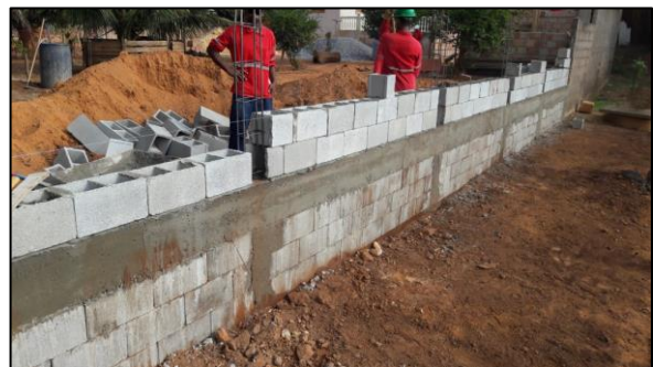
Reforma de quintais e lotes em Barra Longa - maio/2018 (Crédito: Divulgação Fundação Renova)
