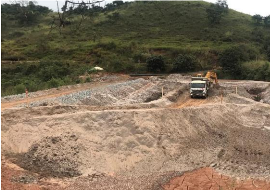
Setor 1: Remoção de Sedimento para Descomissionamento Final – maio/2018 (Crédito: Divulgação Fundação Renova)
