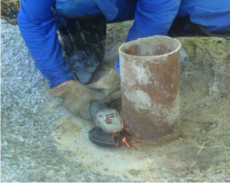
Tamponamento de poços em Itueta - maio/2018 (Crédito: Divulgação Fundação Renova)
