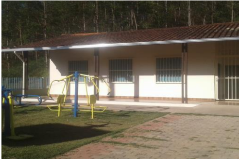
Reforma de edificação - Centro Comunitário Ponte do Gama - Mariana - maio/2018 (Crédito: Divulgação Fundação Renova)
