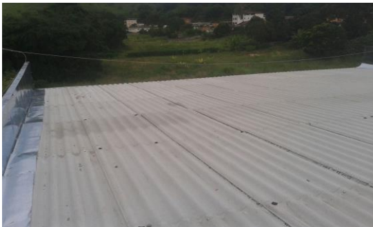
Execução de telhado Escola de Gesteira - maio/2018 (Crédito: Divulgação Fundação Renova)
