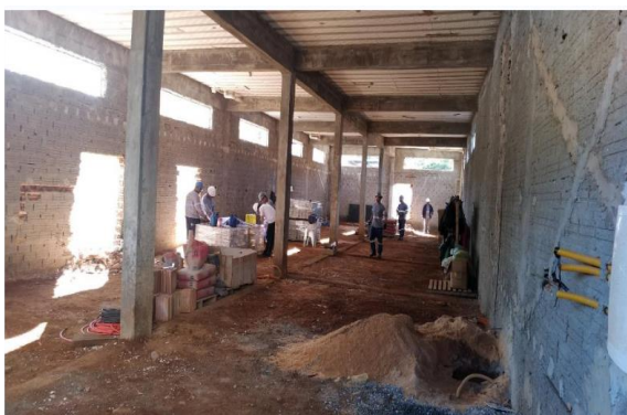
Obras nova estrutura temporária da Escola de Paracatu de Baixo –maio/2018 (Crédito: Fundação Renova)
