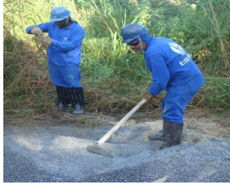
Tamponamento de poços - maio/2018 (Crédito: Divulgação Fundação Renova)
