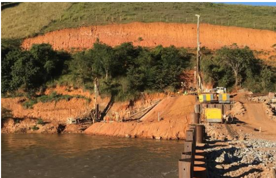
Conclusão da instalação da infraestrutura de monitoramento da estrutura do barramento metálico C- maio/2018 (Crédito: Divulgação Fundação Renova)
