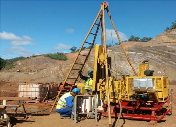
Injeção de concreto – maio/2018 (Crédito: Divulgação Fundação Renova)
