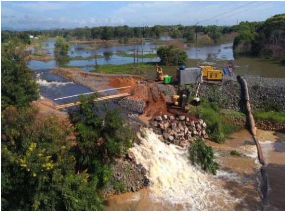
Conclusão do canal lateral do barramento em Linhares – Abril/2018 (Crédito: Divulgação Fundação Renova)
