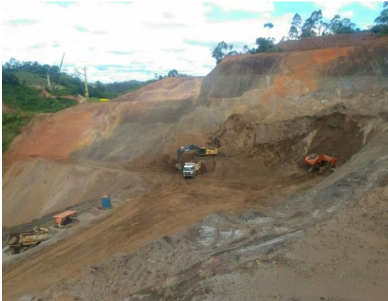
Limpeza de rejeito – abril/2018 (Crédito: Divulgação Fundação Renova)
