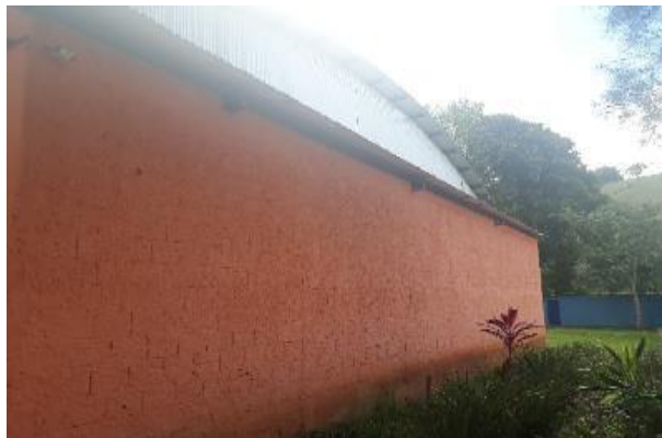
Instalação de Câmeras de Monitoramento na Escola Estadual Padre José – abril/2018
