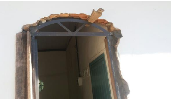
Instalação de porta Capela N. Sra Aparecida Ponte do Gama – abril/2018 (Crédito: Divulgação Fundação Renova)
