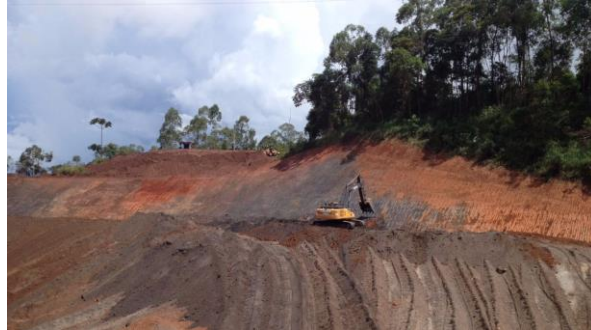
Limpeza do rejeito – março/2018 (Crédito: Divulgação Fundação Renova)
