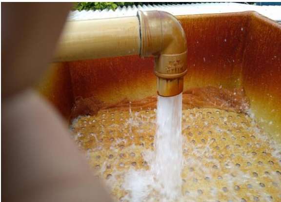
Intervenções e limpeza de poço ligado à ETA de Linhares – Regência – Abril/2018 (Crédito: Divulgação Fundação Renova)
