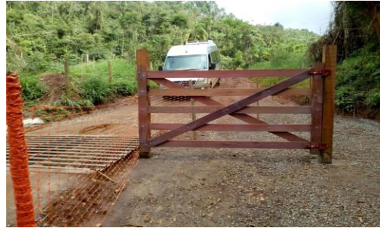
Construção de mata burro em Mariana (Propr. Sebastião Celestino) – abril/2018 (Crédito: Divulgação Fundação Renova)
