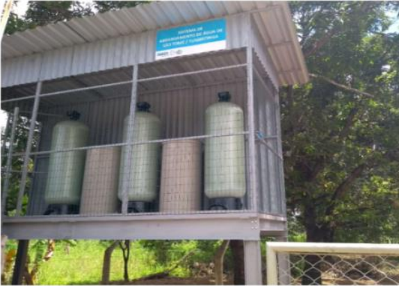
Nova estrutura do sistema de abrandamento – Tumiritinga – São Tomé do Rio Doce – Abril/2018 (Crédito: Divulgação Fundação Renova)
