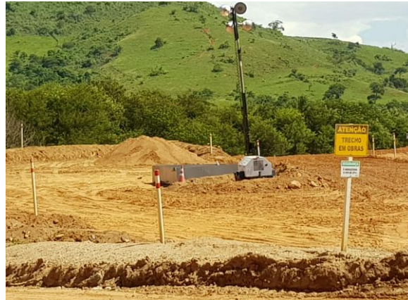
Instalação bacia de contenção – Abril/2018 (Crédito: Divulgação Fundação Renova)
