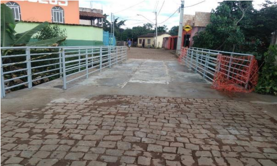
Reforma de passarela de ponte em Santa Rita Durão – abril/2018 (Crédito: Divulgação Fundação Renova)
