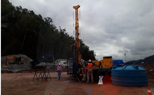
Início das sondagens dos pátios de estocagem – março/2018 (Crédito: Divulgação Fundação Renova)
