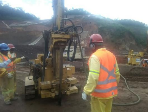
Injeção de cimento – março/2018 (Crédito: Divulgação Fundação Renova)
