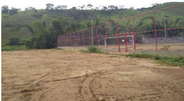
Reaterro do local da drenagem no campo Barralanguense – março/2018 (Crédito: Divulgação Fundação Renova)
