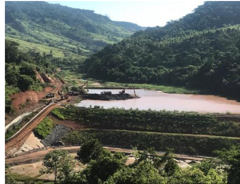
Setor 4 – Remoção de Sedimentos – março/2018 (Crédito: Divulgação Fundação Renova)
