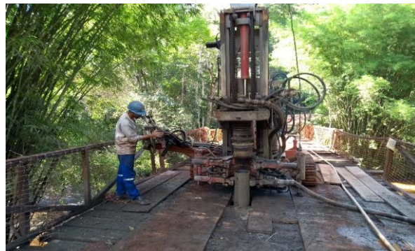
Execução de estaca raiz na ponte Mariana x Bento – março/2018 (Crédito: Divulgação Fundação Renova)
