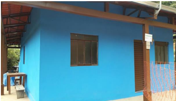
Pintura em residência em propriedade rural em Mariana – março/2018 (Crédito: Divulgação Fundação Renova)
