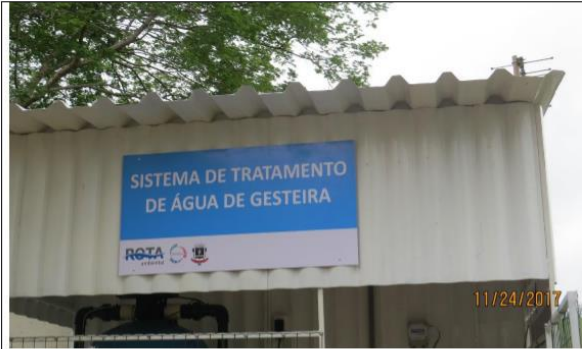
Figura 38 - Placa com a identificação do sistema e distrito.
