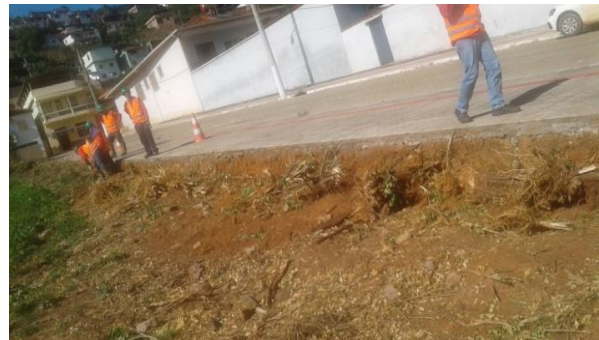
Remoção de cerca viva e instalação de cerca – março/2018 (Crédito: Divulgação Fundação Renova)
