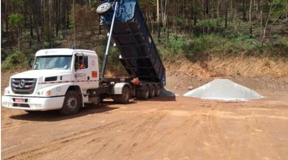
Descarregamento dos agregados nos pátios para execução do alteamento do Eixo 1 - janeiro/2018 (Crédito: Divulgação Fundação Renova)
