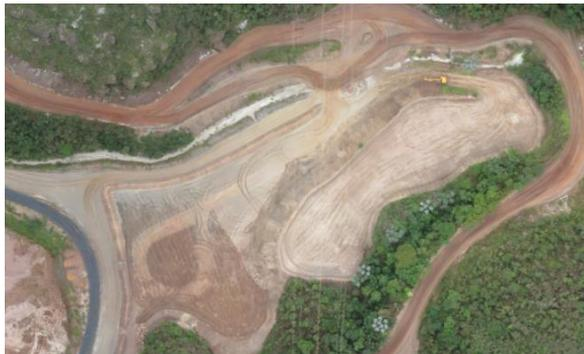
Preparação dos pátios para estocagem dos agregados para execução do alteamento do Eixo 1 - janeiro/2018 (Crédito: Divulgação Fundação Renova)
