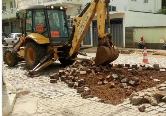
Execução de recuperação de piso de concreto inter travado sextavado, com reaproveitamento de blocos existentes, em Barra Longa - novembro/2017
