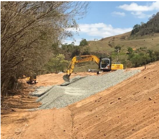
Aterro Bacia 02 FF – outubro/2017 (Crédito: Divulgação Fundação Renova)
