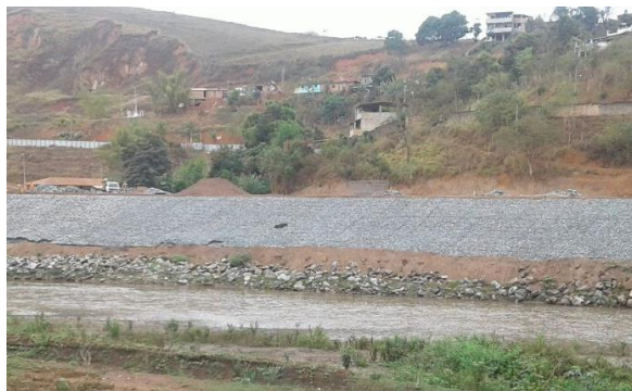
Colchão reno e gabião no Parque de Exposições, em Barra Longa (MG) – outubro/2017 (Crédito: Divulgação Fundação Renova)
