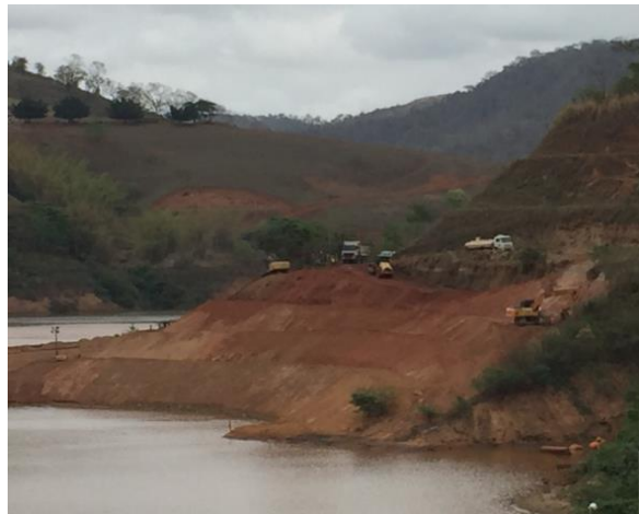
Retaludamento P2 – recuperação das margens do Reservatório – outubro/2017 (Crédito: Divulgação Fundação Renova)
