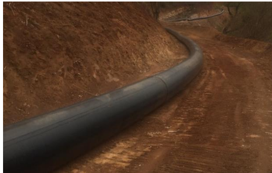
Execução linha Pead – outubro/2017 (Crédito: Divulgação Fundação Renova)
