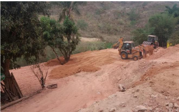
Terraplenagem na propriedade da Maria Conceição – outubro/2017 (Crédito: Divulgação Fundação Renova)
