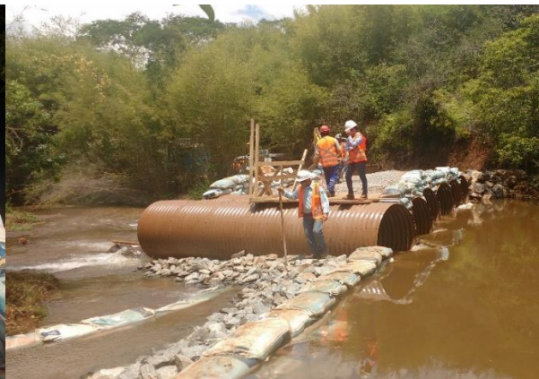
Execução de Encabeçamento lado Bento da ponte Mariana-Bento Rodrigues, em Bento Rodrigues – outubro/2017 (Crédito: Divulgação Fundação Renova)
