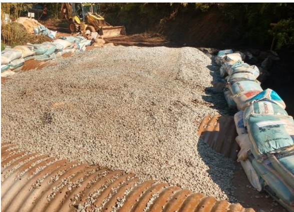
Aterro entre tubos da ponte Mariana-Bento Rodrigues – outubro/2017 (Crédito: Divulgação Fundação Renova)
