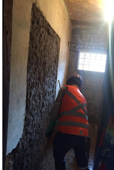
Revestimento das paredes do Sr. Melquiadeas em Mariana (MG) – outubro/2017 (Crédito: Divulgação Fundação Renova)
