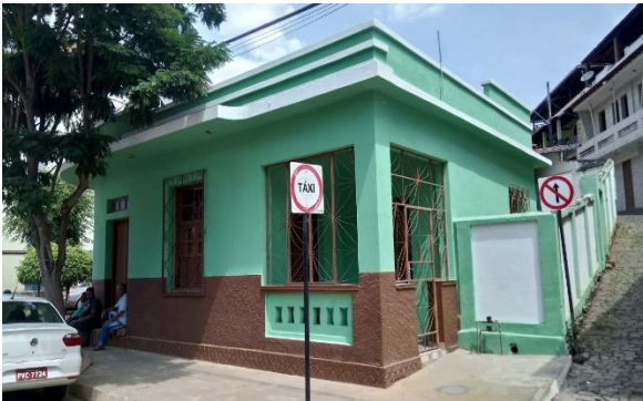
Entrega da reforma da Casa de Cultura, em Barra Longa (MG) – outubro/2017 (Crédito: Divulgação Fundação Renova)
