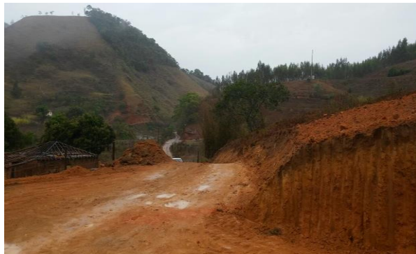
Terraplenagem na propriedade da Tereza Tette – outubro/2017 (Crédito: Divulgação Fundação Renova)
