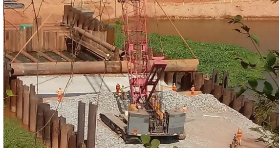
Cravação de estacas metálicas do Barramento C – outubro/2017 (Crédito: Divulgação Fundação Renova)
