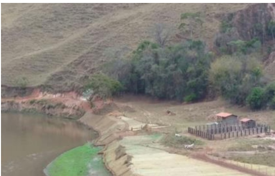
Serviços de bioengenharia na área não prioritária 27 em Barra Longa (MG) – outubro/2017 (Crédito: Divulgação Fundação Renova)
