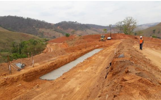
Drenagem superficial diques FF – outubro/2017 (Crédito: Divulgação Fundação Renova)
