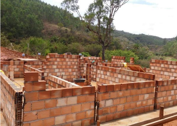
Execução de alvenaria na propriedade do Márcio de Souza – outubro/2017 (Crédito: Divulgação Fundação Renova)
