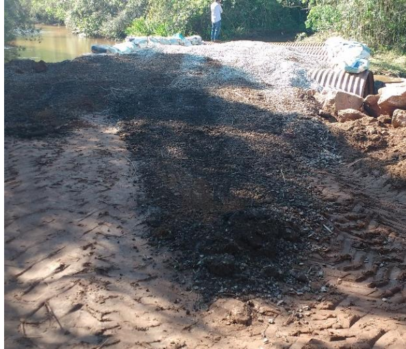
Execução de encabeçamento da ponte Mariana-Bento Rodrigues, em Mariana (MG) – outubro/2017 (Crédito: Divulgação Fundação Renova)
