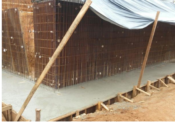
Concretagem no pé do muro de contenção na propriedade do Arlindo – outubro/2017 (Crédito: Divulgação Fundação Renova)
