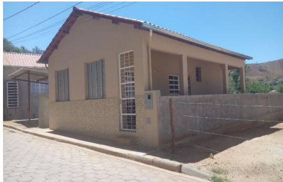
Entrega de casa reconstruída, em Barra Longa (MG) – outubro/2017 (Crédito: Divulgação Fundação Renova)
