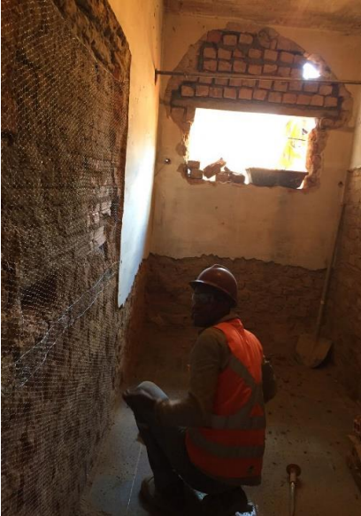
Demolição das paredes do Sr. Melquiadeas em Mariana (MG) – outubro/2017 (Crédito: Divulgação Fundação Renova)
