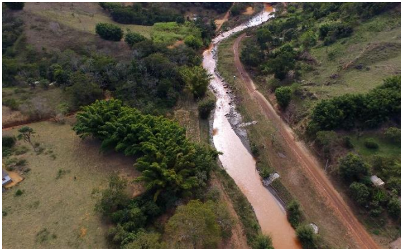
Serviços de bioengenharia na área não prioritária 24 em Mariana (MG) – Vista aérea de setembro/2017 (Crédito: Divulgação Fundação Renova)
