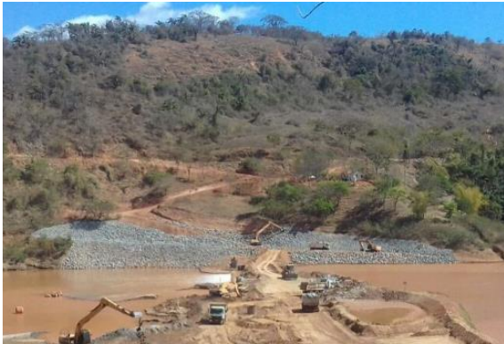
Retaludamento ponto 151- recuperação das margens do reservatório – setembro/2017 (Crédito: Divulgação Fundação Renova)
