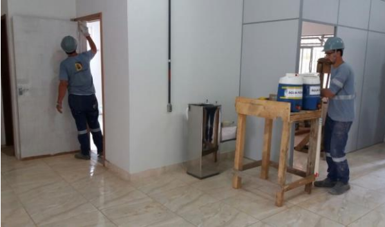
Obras na Escola Municipal José de Vasconcelos Lana, em Barra Longa (MG) – setembro/2017 (Crédito: Divulgação Fundação Renova)
