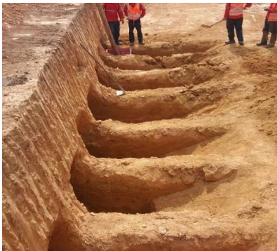
Atividades da estação de transbordo - setembro/2017 (Crédito: Divulgação Fundação Renova)
