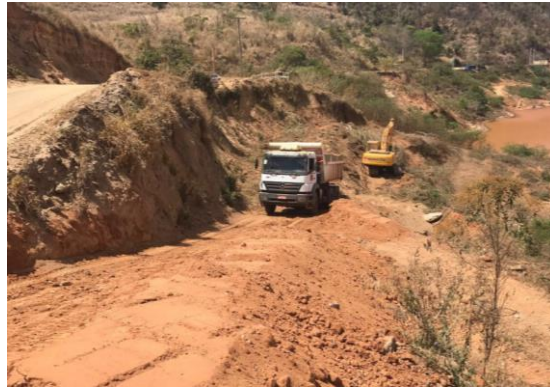
Retaludamento P2 – recuperação das margens do Reservatório – setembro/2017 (Crédito: Divulgação Fundação Renova)
