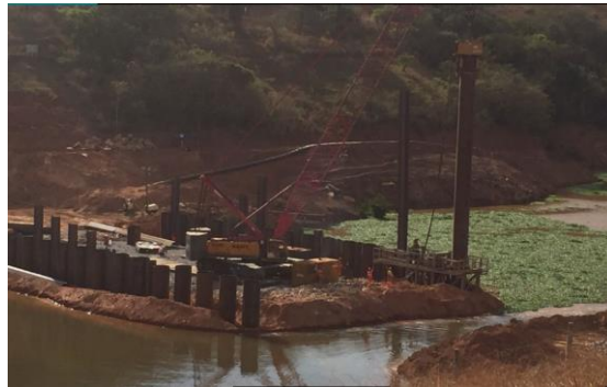
Cravação de estacas metálicas do Barramento C - setembro/2017 (Crédito: Divulgação Fundação Renova)
