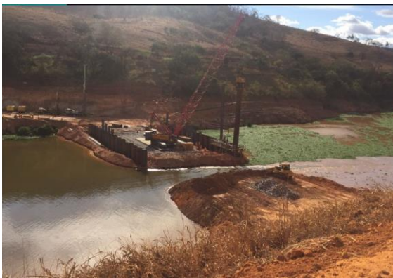
Aterro de Conquista no Barramento C - setembro/2017 (Crédito: Divulgação Fundação Renova)
