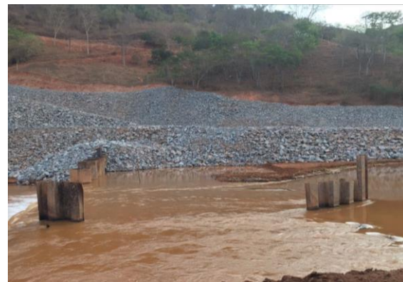
Conclusão do Barramento A - setembro/2017 (Crédito: Divulgação Fundação Renova)
