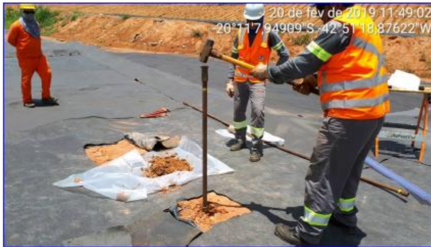
Execução da sondagem ST-06
