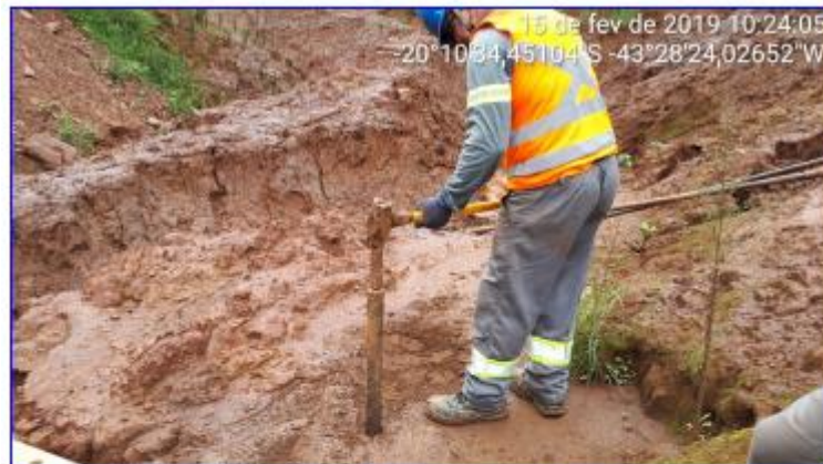
Execução da sondagem ST-03
