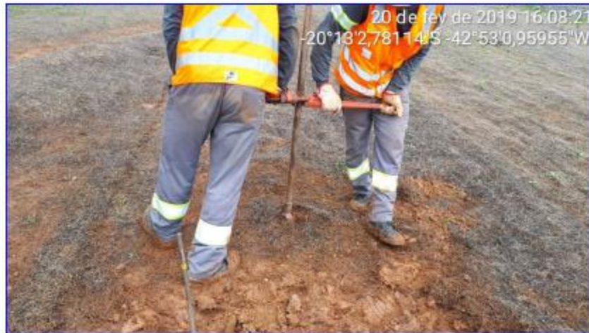
Execução da sondagem ST-07
