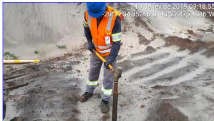
Execução da sondagem ST-04
