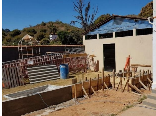
Obras na escola José de Vasconcelos Lanna – 30 de agosto/2017 (Crédito: Divulgação Fundação Renova)
