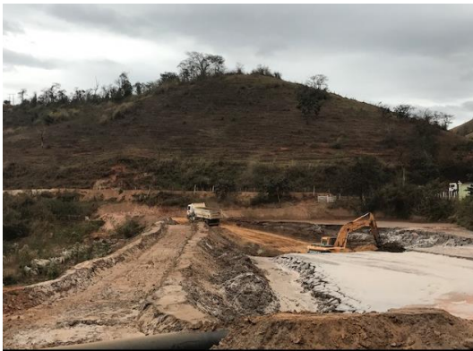
Dragagem Setor 1 – Recuperação Mecânica – agosto/2017 (Crédito: Divulgação Fundação Renova)
