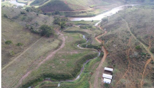
Situação atual do Tributário TC05 - Rio do Carmo em Barra Longa (MG) – agosto/17 (Crédito: Divulgação Fundação Renova)
