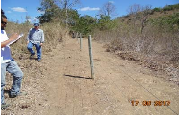
Execução de aceiramento nas propriedades - agosto/2017 (Crédito: Divulgação Fundação Renova)
