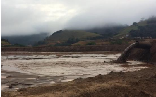
Dragagem no Setor 8 A – agosto/2017 (Crédito: Divulgação Fundação Renova)
