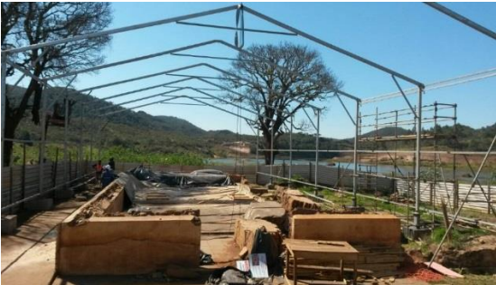
Construção da nova tenda de proteção as ruínas da Capela de São Bento - Bento Rodrigues – agosto/2017 (Crédito: Divulgação Fundação Renova)
