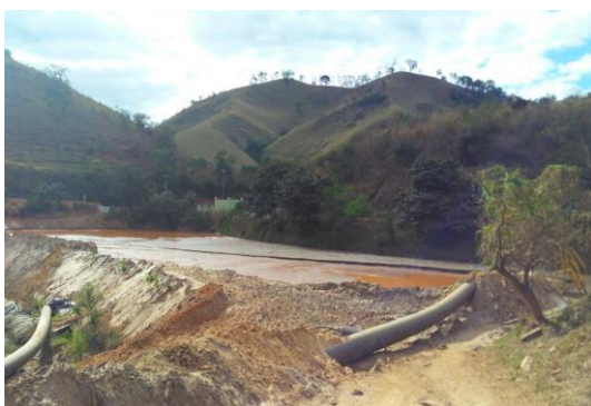
Dragagem Setor 1 – julho/2017 (Crédito: Divulgação Fundação Renova)
