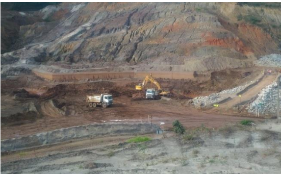
Limpeza Eixo 1. (Crédito: Divulgação Fundação Renova)
