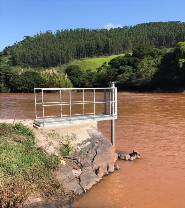
Estação automática do Tipo II instalada no rio Doce em Santa Cruz do Escalvado/MG (código RDO01) – julho 2017 (Divulgação:
