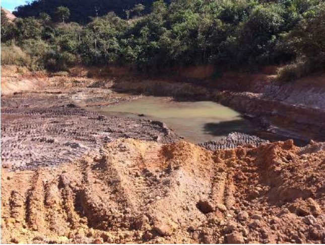
Abertura de frente de deposição de material dragado do Setor 5 (Crédito: Divulgação Fundação Renova)
