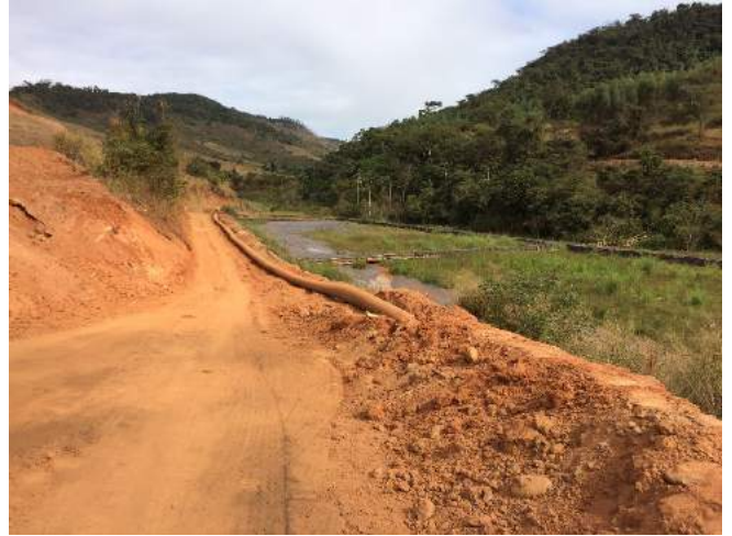
Dragagem para a paliçada no Setor (Crédito: Divulgação Fundação Renova)
