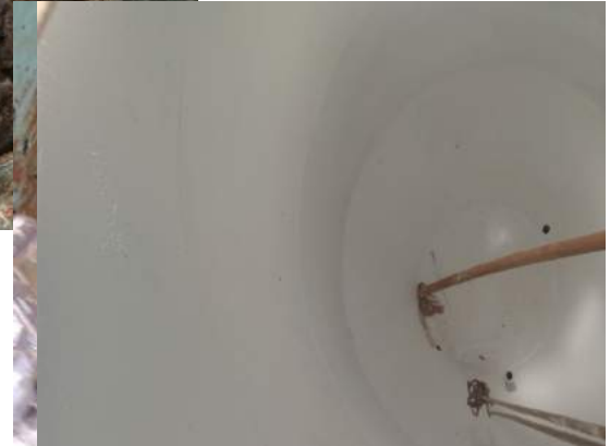
Jateamento do interior da torre de armazenamento de água durante a manutenção (à esquerda) e resultado da pintura no mesmo interior (à direita). (Crédito: Divulgação Fundação Renova)
