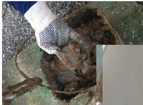
Interior da torre de armazenagem de água com o lodo retirado. (Crédito: Divulgação Fundação Renova)
