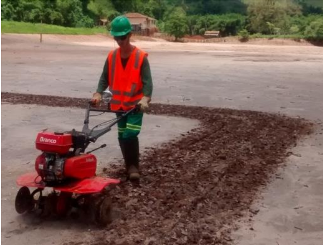
Figura 37: Preparação semi-mecanizada do substrato utilizando motocultivador nas proximidades de Barra Longa.
