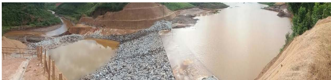
Figura 35 - Obras no dique S4 concluídas.
