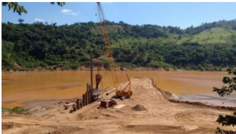
Figura 33: Visualização geral do avanço das obras do Barramento A.
