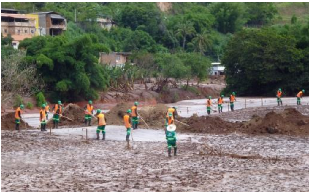
Figura 36: Microcoveamento manual do solo com uso de enxadinhas nas proximidades de Barra Longa.
