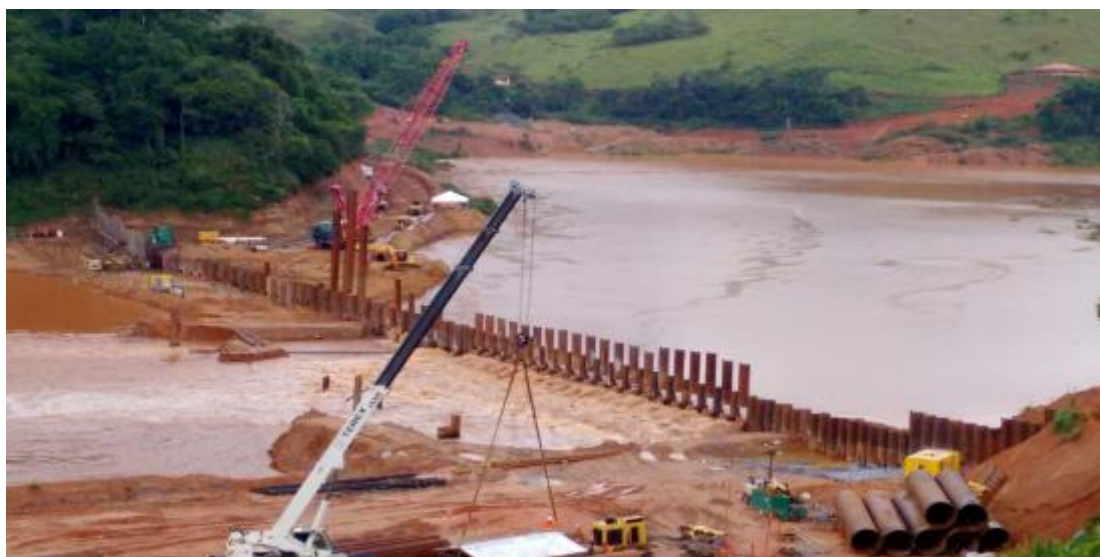
Figura 31: Visualização geral do avanço das obras do Barramento B.
