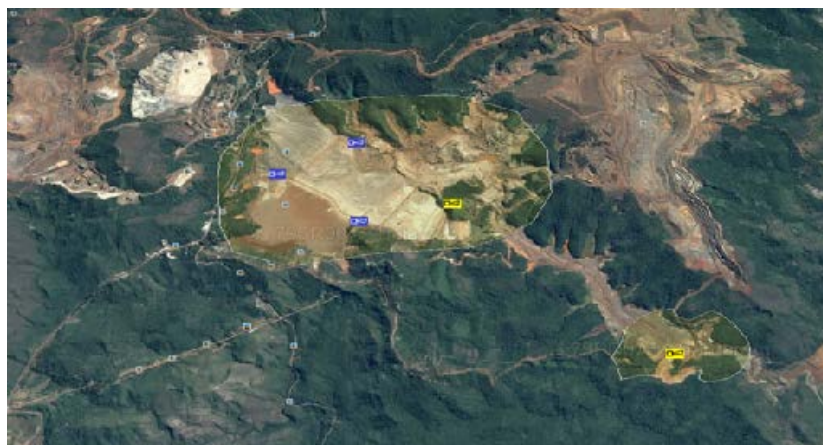
Figura 13: Sirenes da Barragem de Germano e Santarém.
