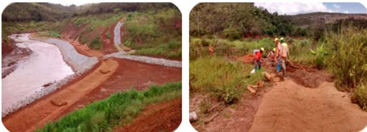
Figura 68: Recuperação ambiental no alto Gualaxo do Norte – Área 3 (esquerda), implantação de canaletas de drenagem – Área 3 (direita).
