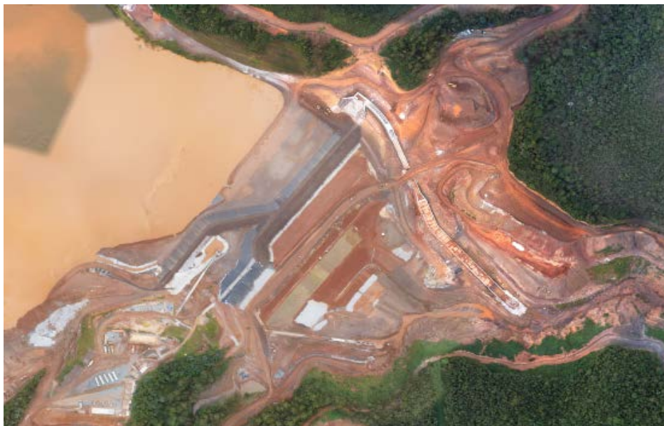
Figura 34: Vista aérea da Nova Barragem Santarém, concluída até a El. 765 m.
