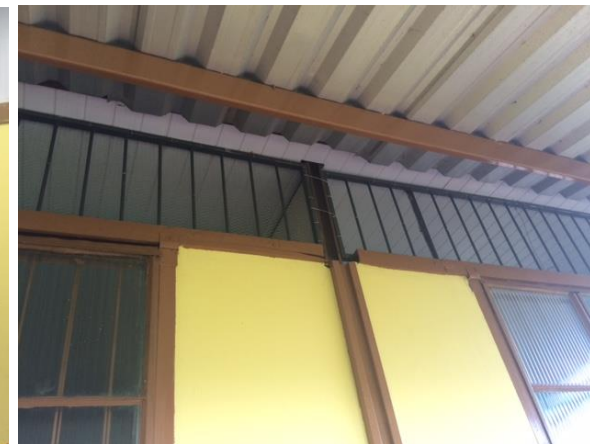
Instalação de grades para segurança
