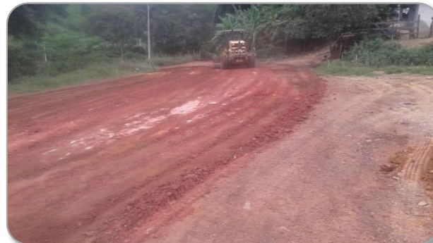
Manutenção de Vias não Pavimentadas Campinas
