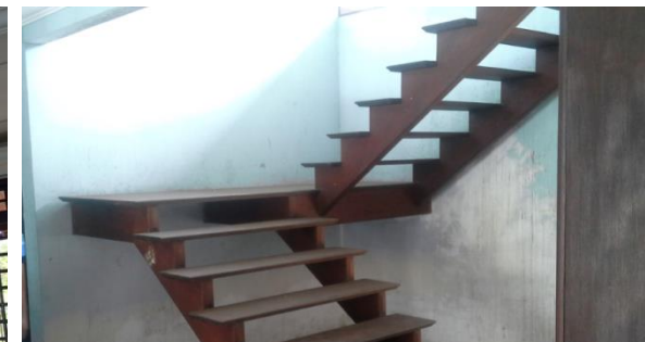
Instalação de corrimão e tela de proteção
