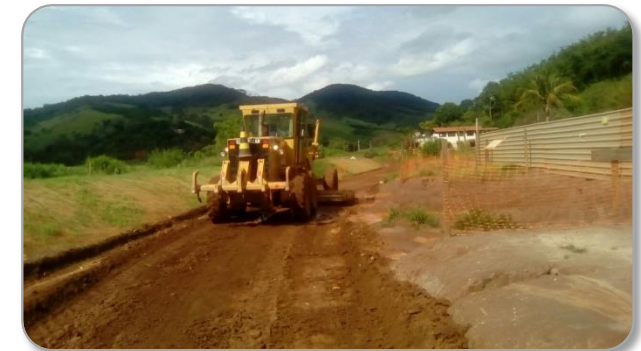
Manutenção de Vias não Pavimentadas Gesteira
