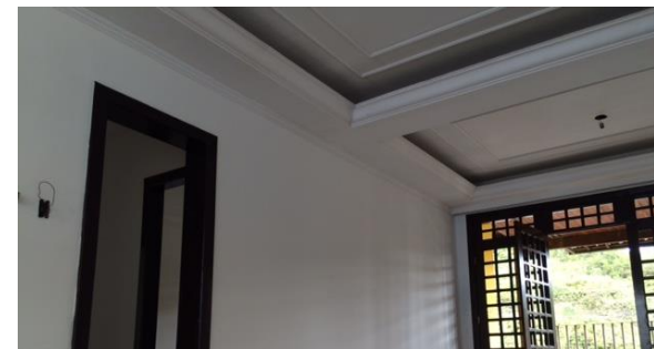
Pintura interna com barramento de 1,5m
