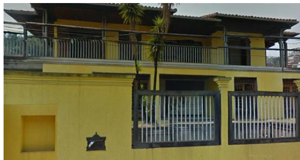
Fachada da escola temporária de Bento Rodrigues
