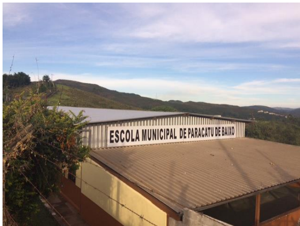
Troca do telhado com isolamento térmico
