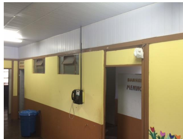
Recuperação do forro em PVC
