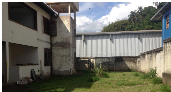
Instalação de alambrado na área externa
