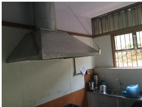
Instalação de coifa na cozinha
