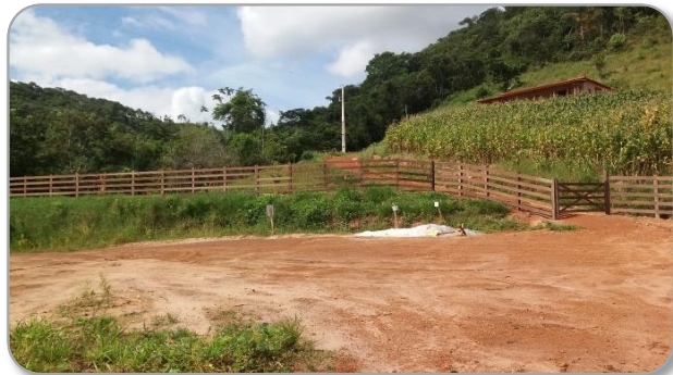
Instalação de Cerca Dona Zeni– Barra Longa
