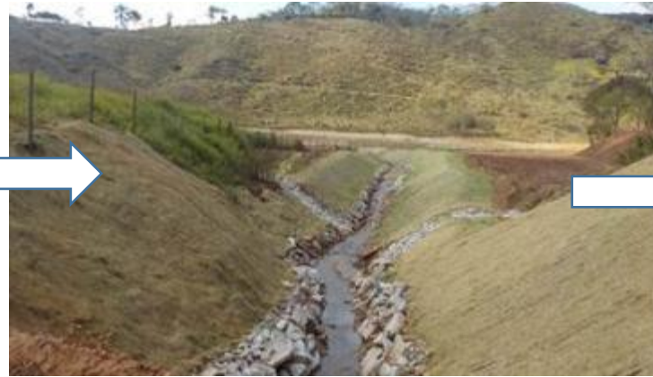
Final da Obra
