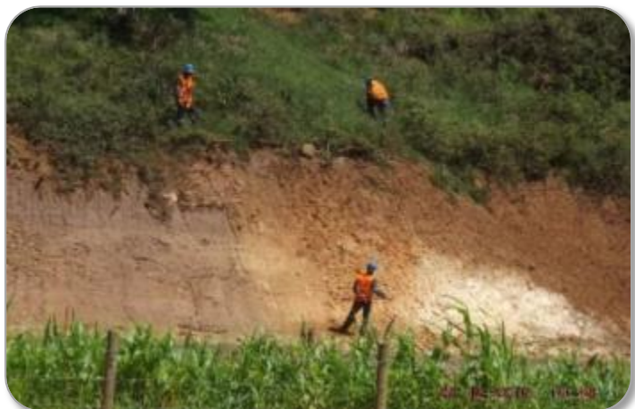
Área 7 – Coveamento e instalação de biomantas
