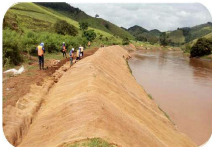
Área 15 – Obras de Bioengenharia
