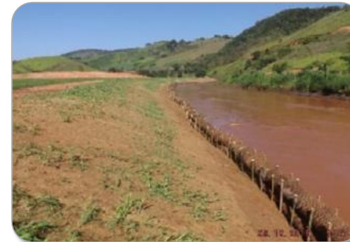
Área 6 – Instalação de biomantas e bermalongas
