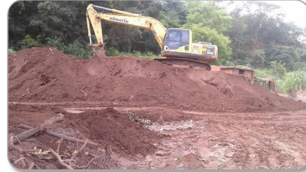
Remoção de resíduos Gesteira
