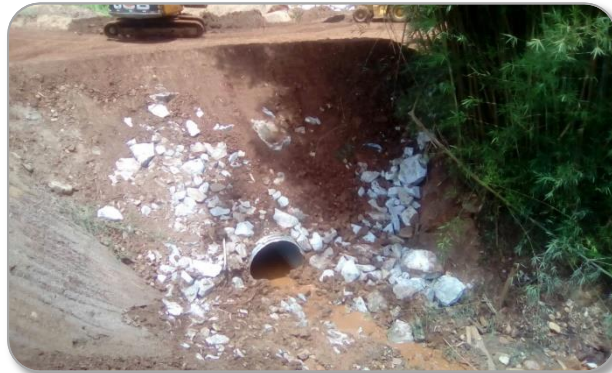
Reforma Bueiro Ponte do Onça – Barra Longa
