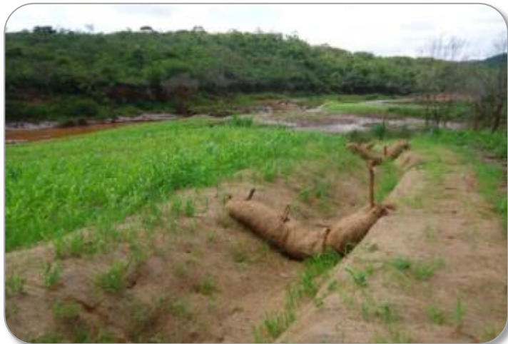
Área 3 – Instalação de retentores de sedimentos na calha de drenagem
