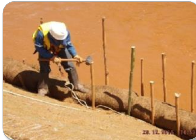
Área 5 – Instalação de bermalonga
