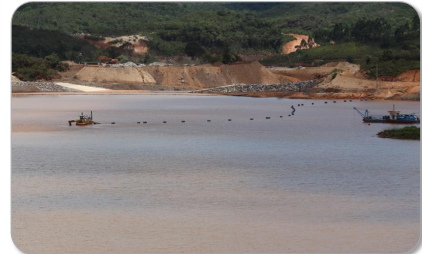
Dragagem - Dique S3
