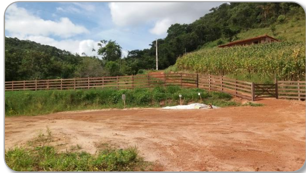
Instalação de Cerca Nazareno (Pedras)
