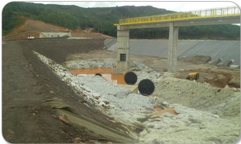
Barragem Nova Santarém
