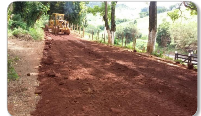
Manutenção de Vias não Pavimentadas Paracatu
