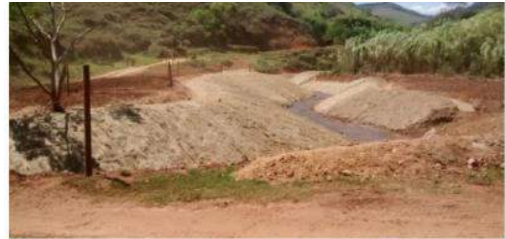
T 07 Rio do Carmo- andamento da obra
