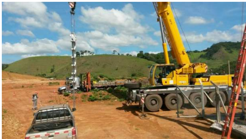
Instalação das 9 sirenes da Fase 2
