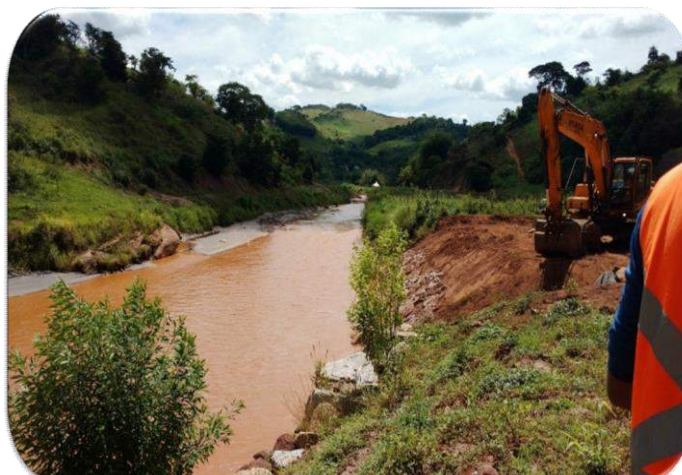
Área 9 – Reconformação de calha
