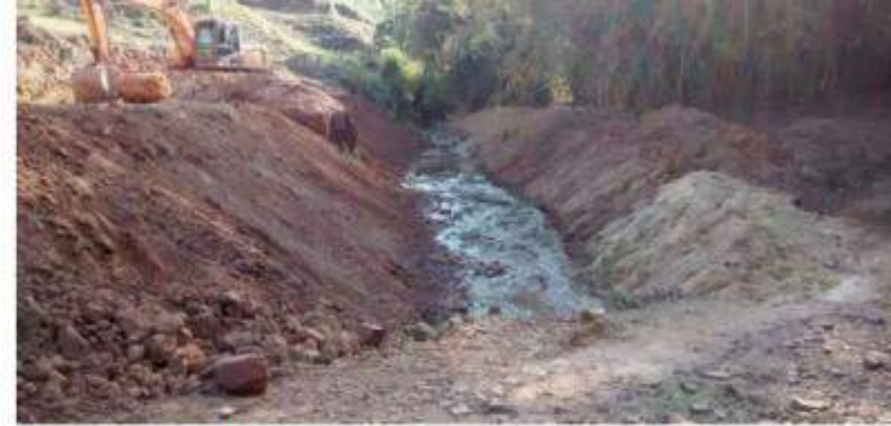
T 08 Rio do Carmo- andamento da obra
