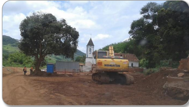
Remoção de resíduos Gesteira
