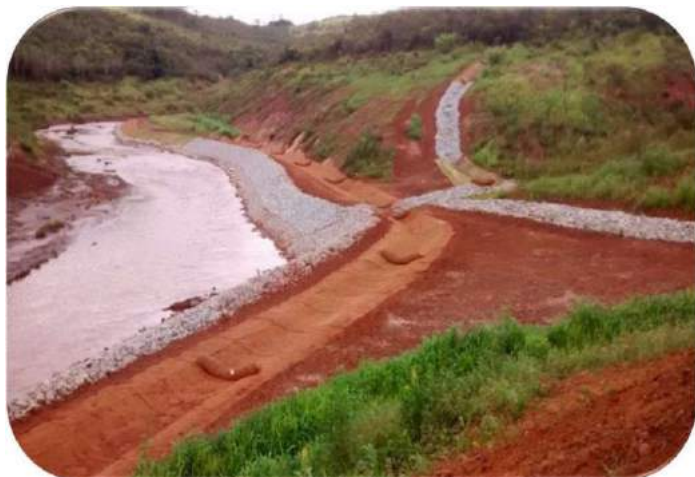
Área 3 – Instalação de canaletas de drenagem
