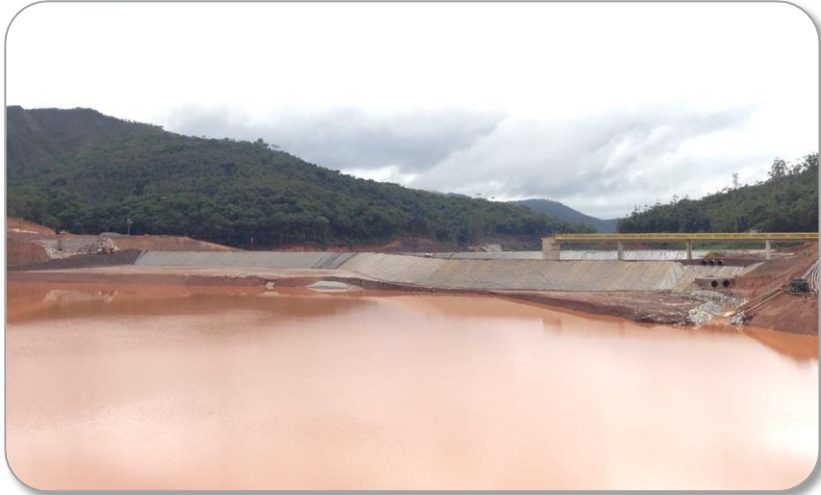
Barragem Nova Santarém
