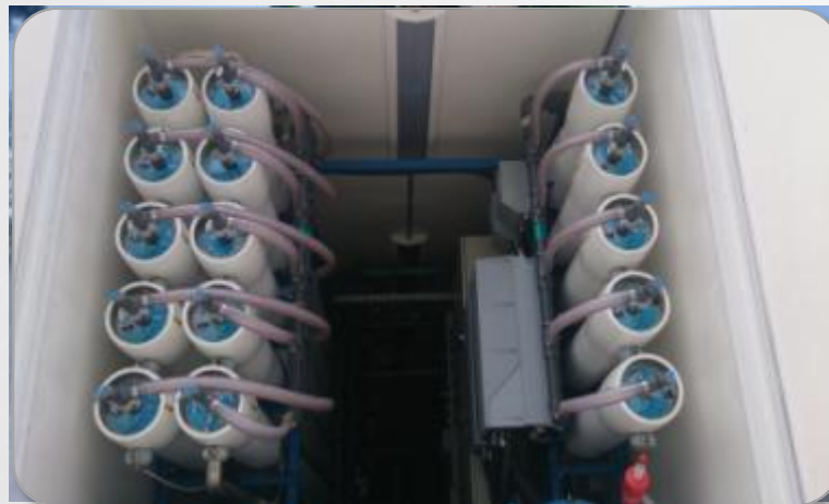
Comissionamento da ETA móvel com Sistema de Osmose Reserva
