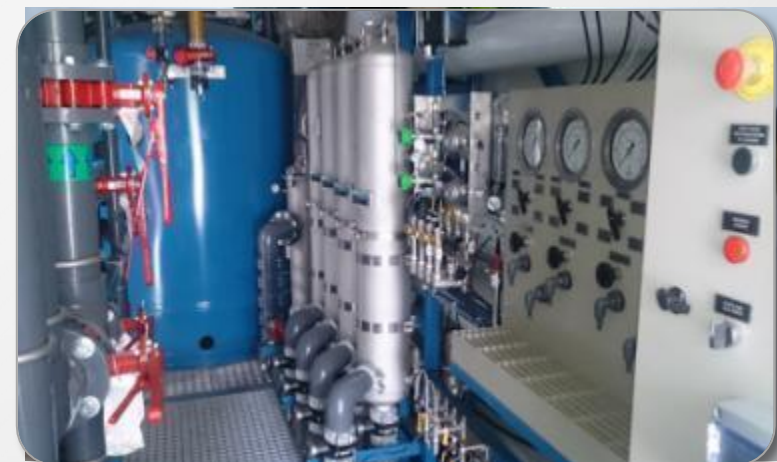
Comissionamento da ETA móvel com Sistema de Osmose Reserva
