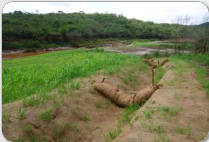
Área 3 – Instalação de retedores de sedimentos na calha de drenagem
