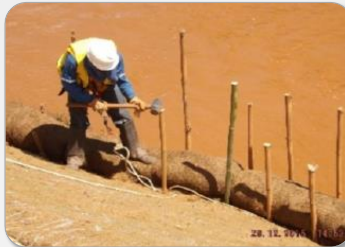
Area 5 – Instalação de bermalonga
