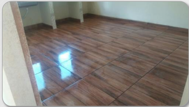
Piso do Centro Comunitário
