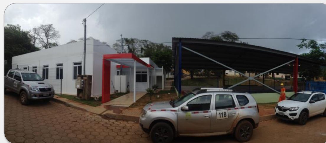
Escola Municipal Gustavo Capanema – Gesteira/Barra Longa
