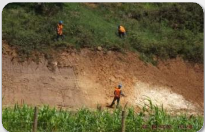
Área 7 – Coveamento e instalação de biomantas
