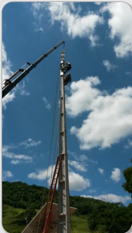
Preparação dos postes da fase 2
