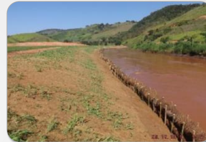
Area 6 – Instalação de biomantas e bermalongas
