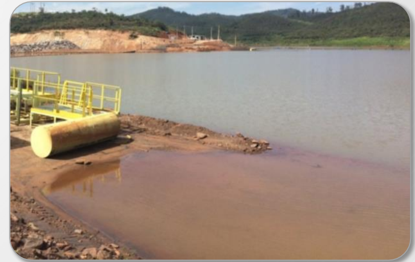
Dragagem - Dique S3
