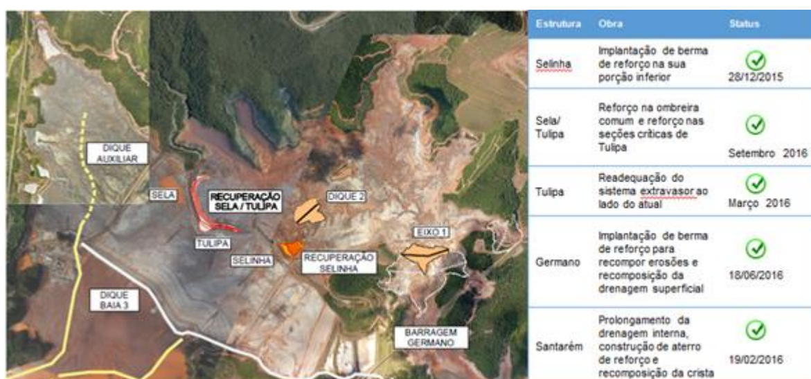
Figura 8: Obras emergenciais de contenção e estabilização realizadas durante o período chuvoso 2015/2016
