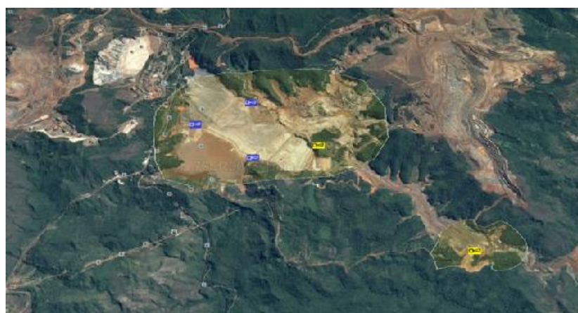
Figura 13: Sirenes da Barragem de Germano e Santarém.
