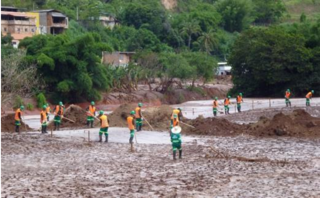
Figura 40: Microcoveamento manual do solo com uso de enxadinhas nas proximidades de Barra Longa.
