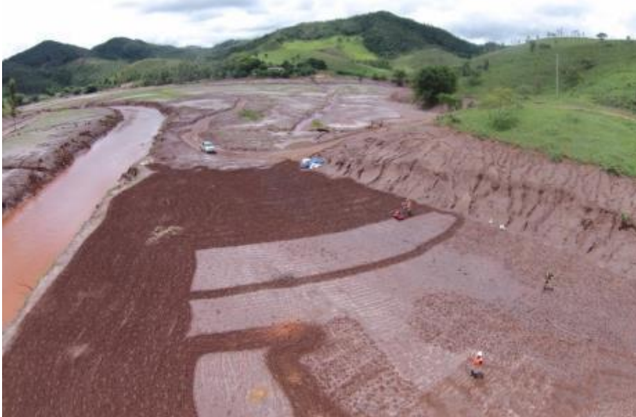
Figura 42: Preparação do solo utilizando métodos manuais e semi-mecanizados de escarificação do substrato, semeadura e fertilização sendo realizadas nas proximidades de Paracatu de Baixo.
