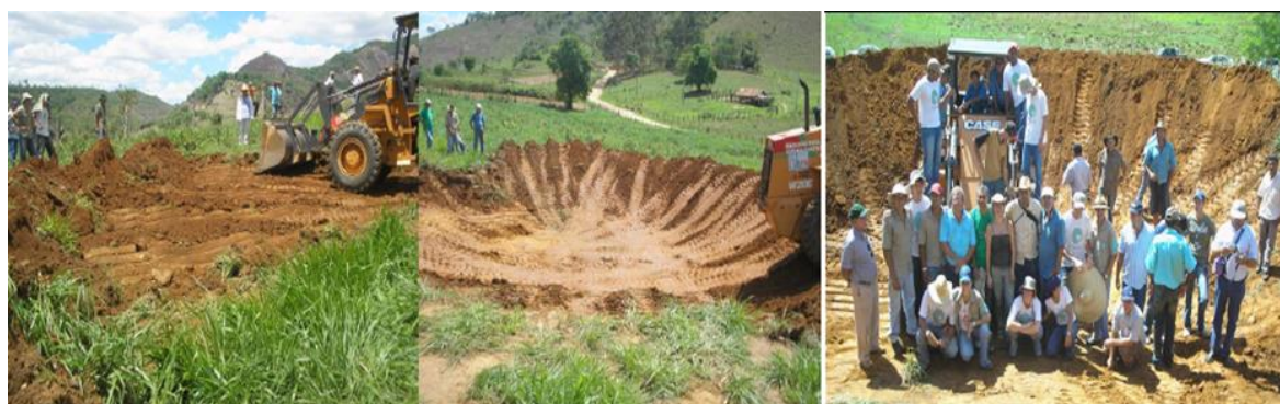
Figura 62 - Representação da implantação de barraginhas (arquivo Instituto Terra).
