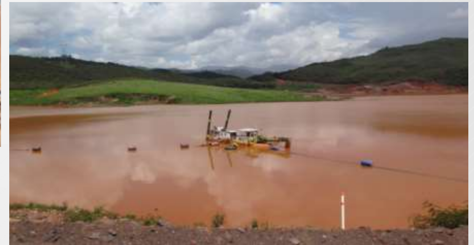
Dragagem - Dique S3
