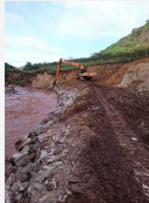
Area 8 – Conformação da calha
