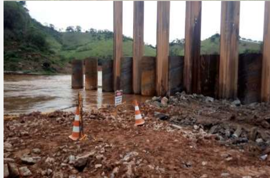
Barreira metálica B
