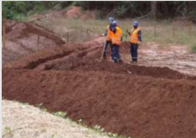
TG037 – Conformação e coveamento do solo
