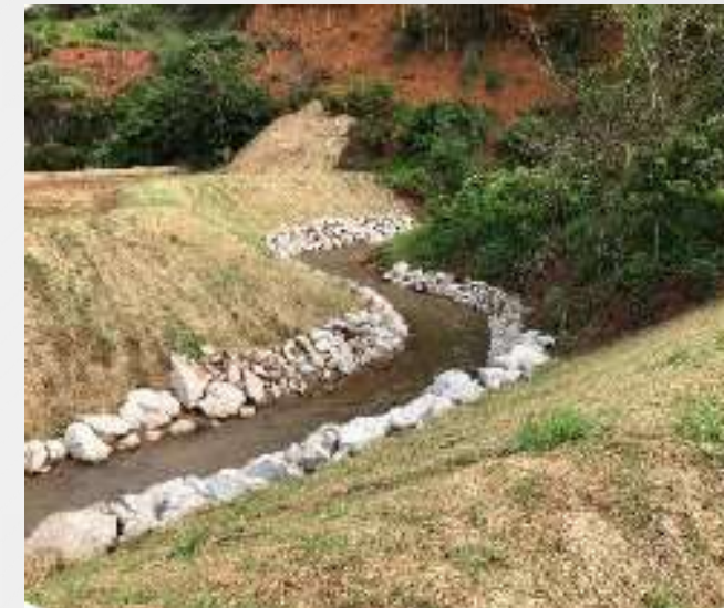
Area 8 – Conformação da calha
