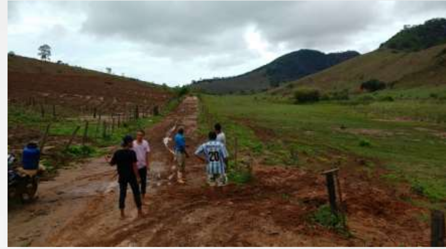
Recuperação dos Acessos TI Krenak
