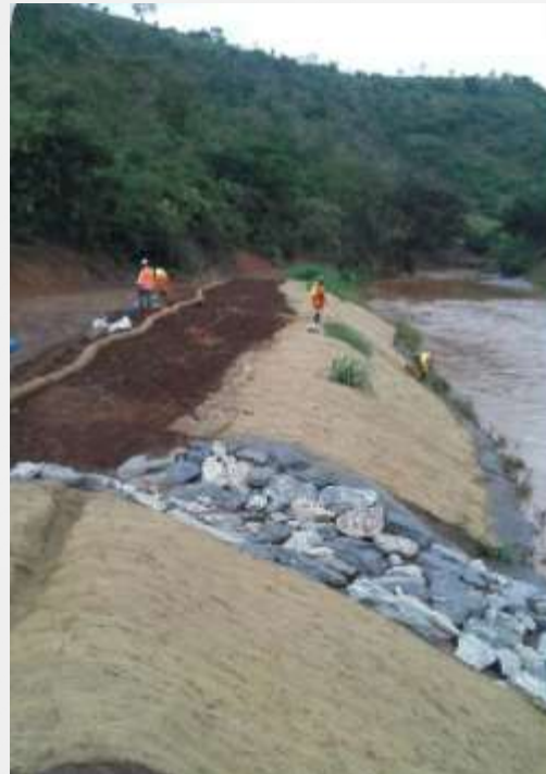
Area 6 – Aplicação biomanta
