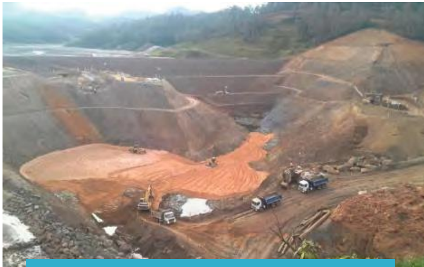
Visão Geral – Nova Barragem Santarém
