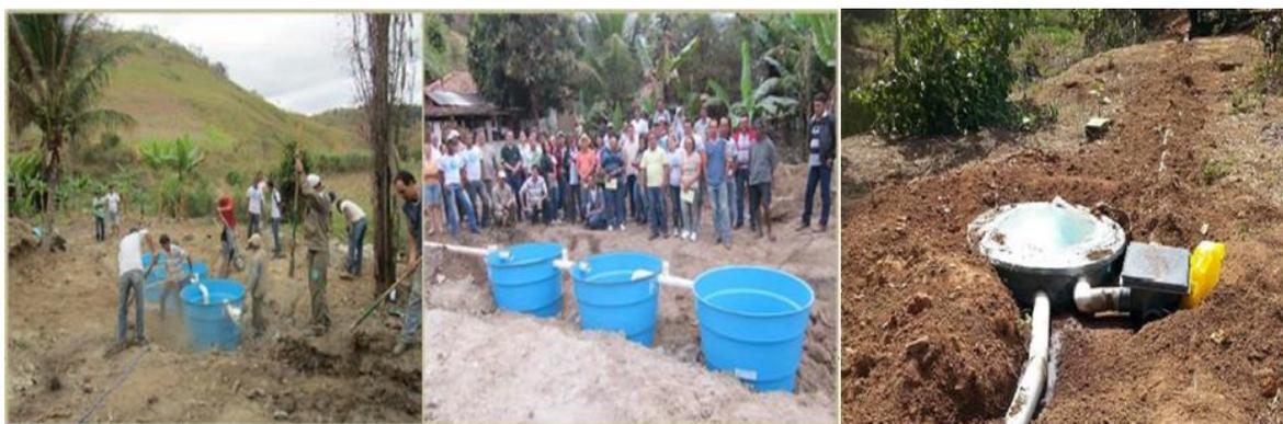
Figura 58 - Representação da instalação de fossas sépticas (arquivo Instituto Terra).
