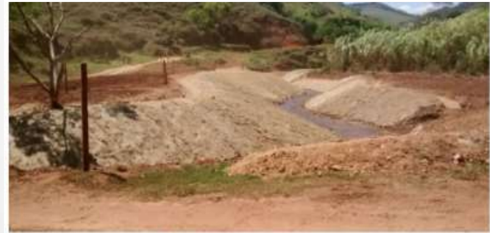
T 07 Rio do Carmo- andamento da obra
