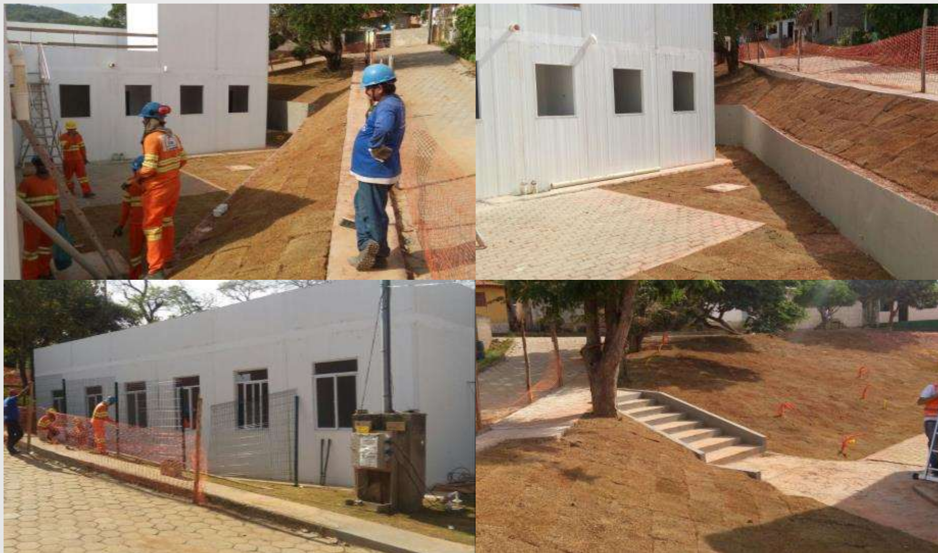
Construção da escola de Gesteira
