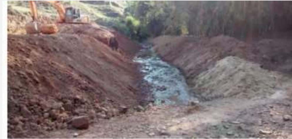
T 08 Rio do Carmo- andamento da obra
