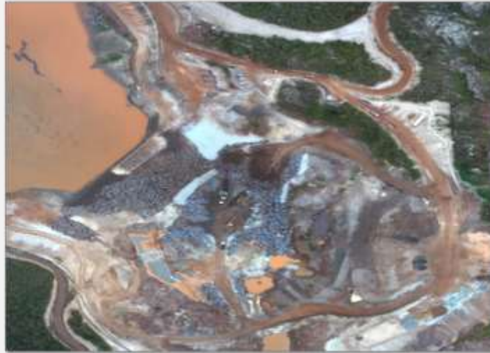
Visão Geral – Dique S3
