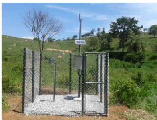
Figura 18: Estação pluviográfica e data logger
