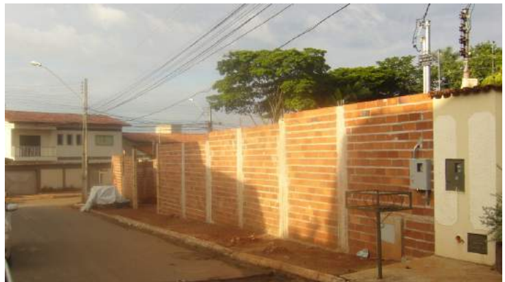
Figura 83 Muro de alvenaria
