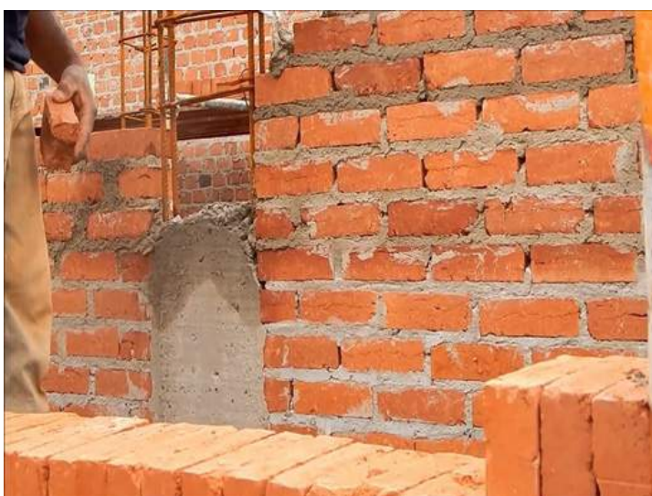
Figura 152 Construção com tijolos maciços
