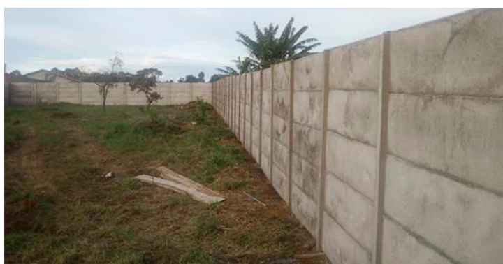
Figura 85 Muro de concreto
