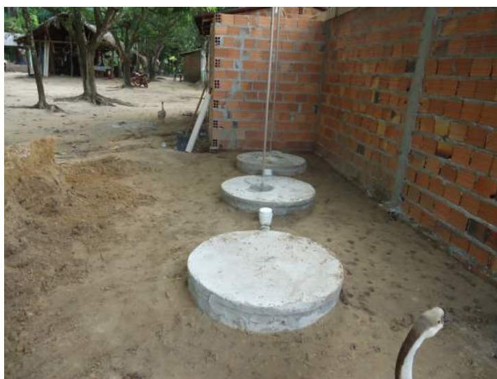
Figura 142 Fossa séptica manilha
