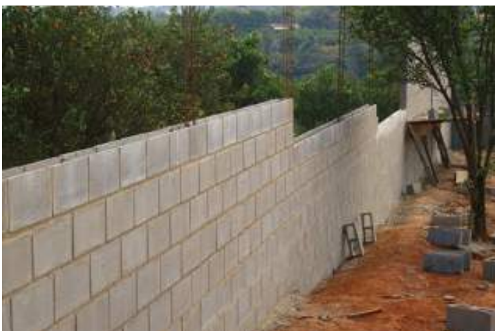
Figura 88 Muro de bloco de concreto cheio
