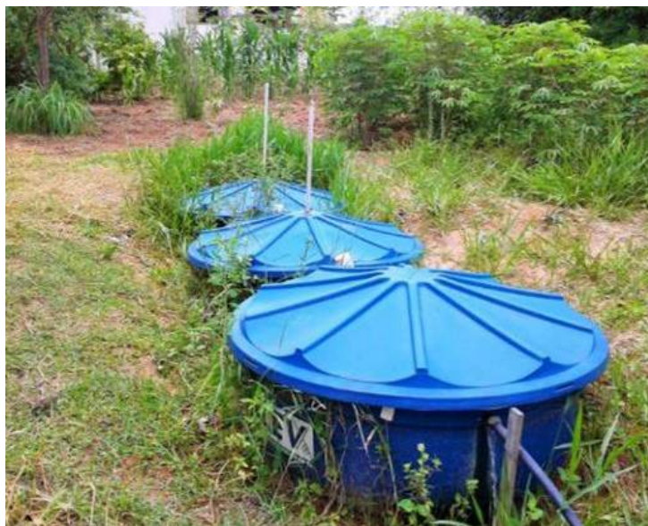
Figura 141 Fossa séptica caixa coletora
