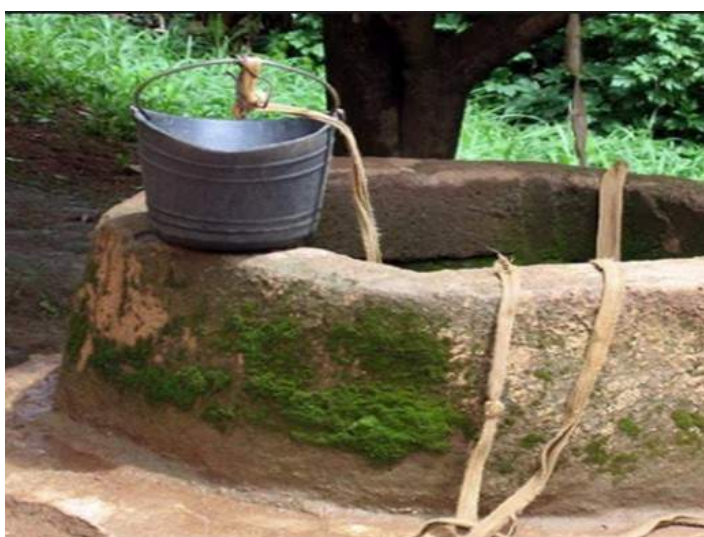
Figura 98 Poço caipira com revestimento
