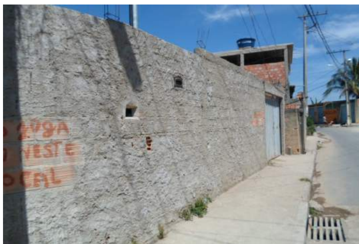
Figura 86 Muro com chapisco
