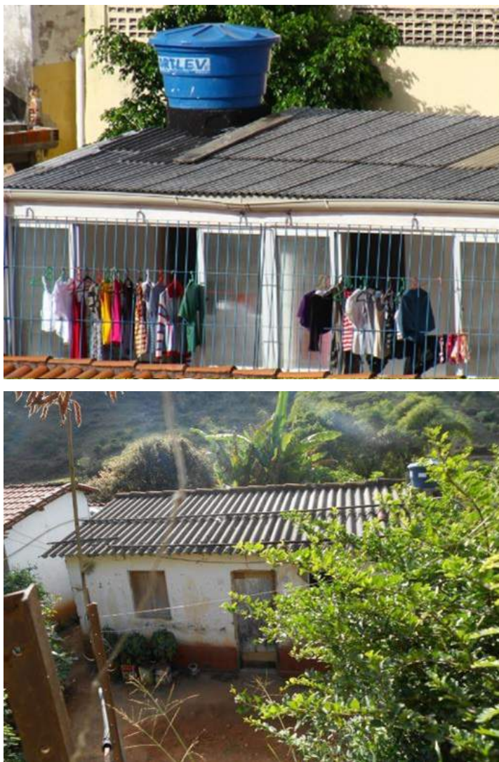
Figura 157 Telha de fibrocimento
