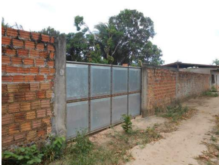
Figura 130 Portão de ferro
