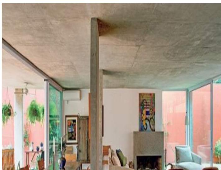
Figura 156 Construção de Laje
