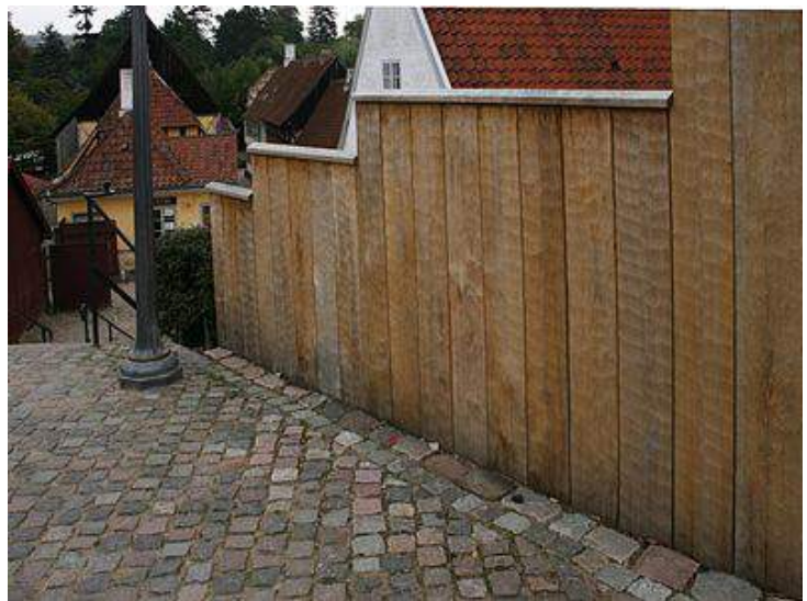
Figura 84 Muro de madeira
