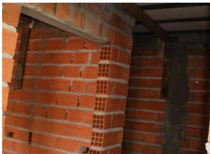
Figura 151 Construção com tijolos furados
