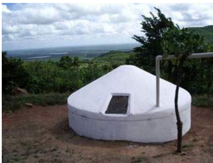
Figura 129 Cisterna de polietileno
