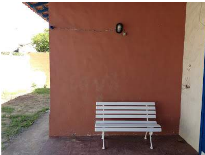
Figura 72 Cosas com estado de conservação de reparos simples
