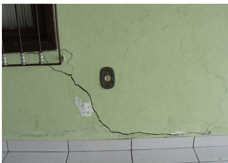
Figura 71 Cosas com estado de conservação regular/ reparos simples
