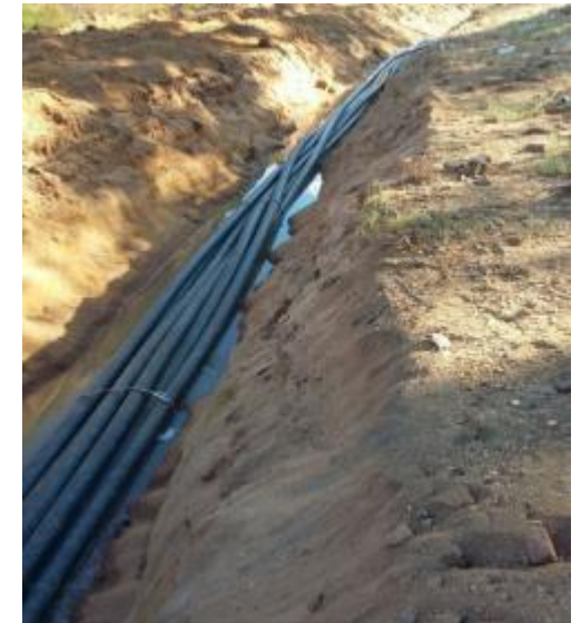
Lançamento de tubulação da adutora do Rio Santa Maria
