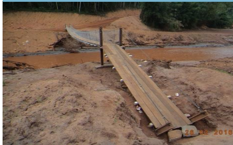
Travessia de cabo de aço
