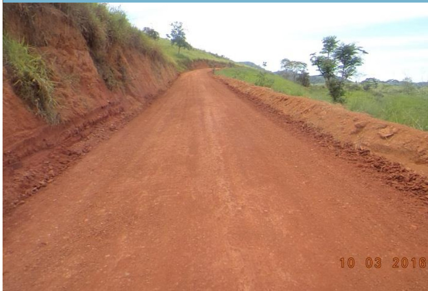
Manutenção em estradas não pavimentadas
