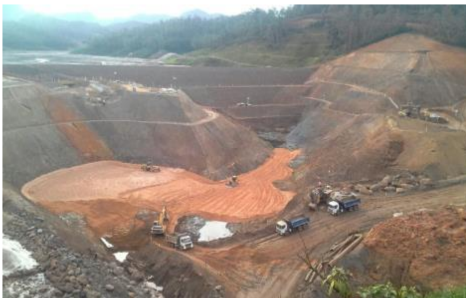
Visão Geral – Nova Barragem Santarém
