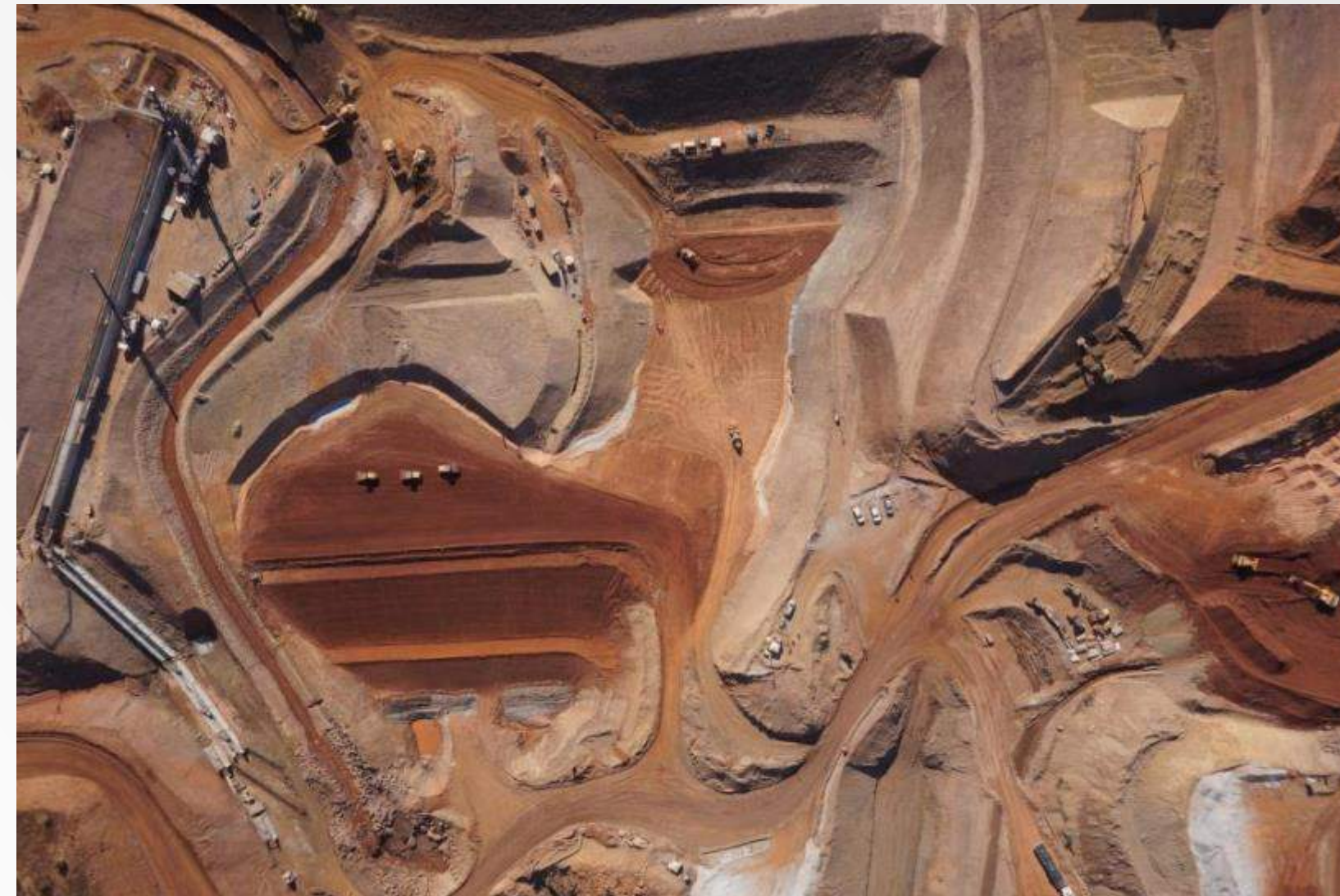
Visão geral – Nova Barragem Santarém
