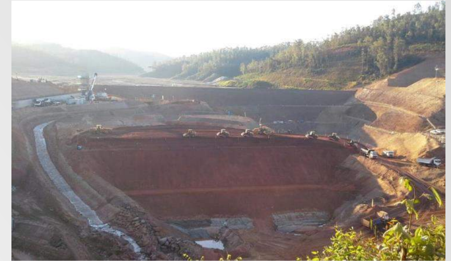
Visão Geral – Nova Barragem Santarém
