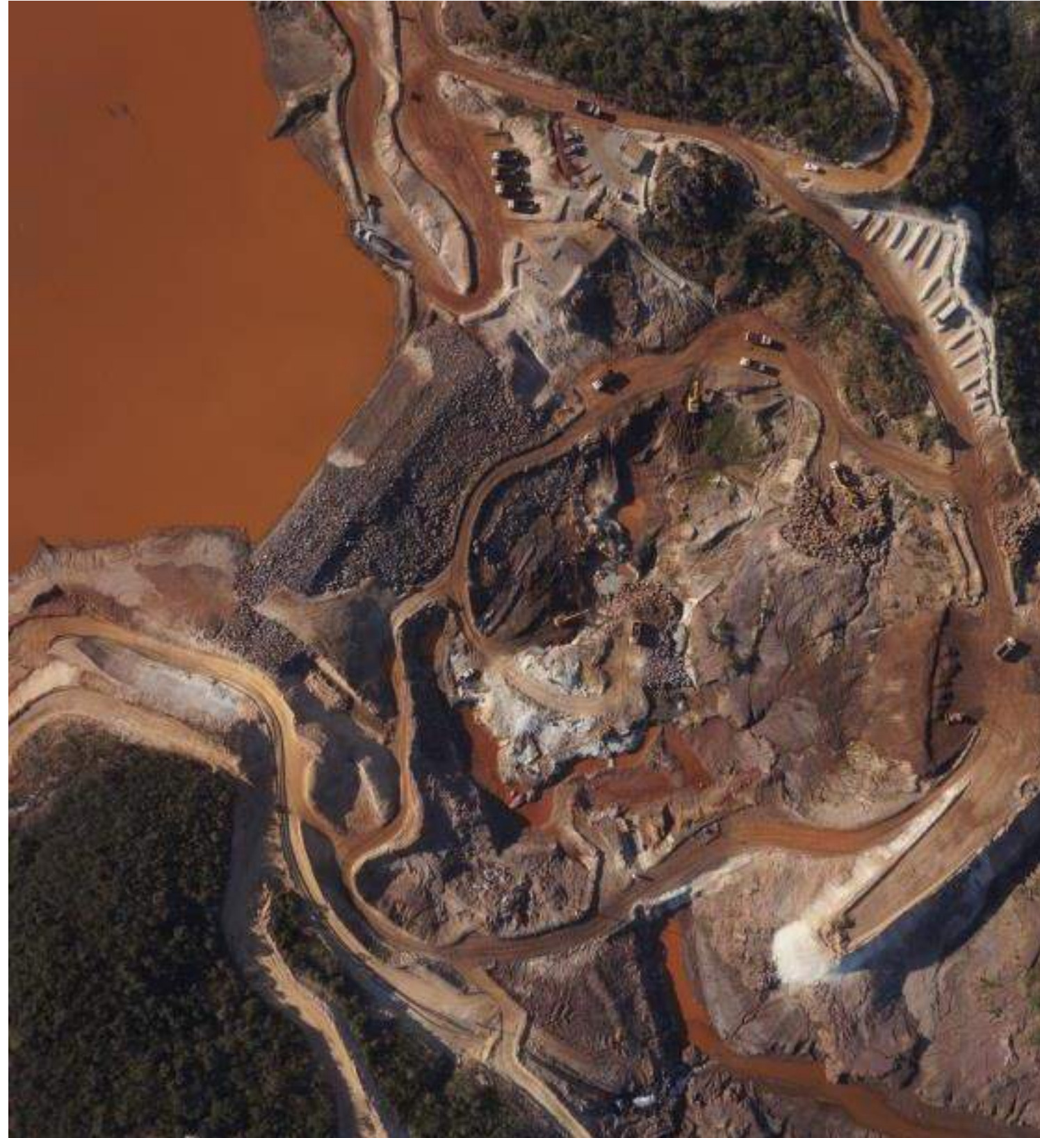
Visão Geral – Dique S3
