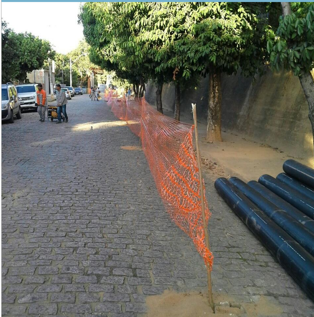
Lançamento da tubulação da adutora do Rio Santa Maria
