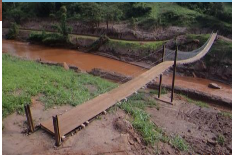
Travessia de cabo de aço
