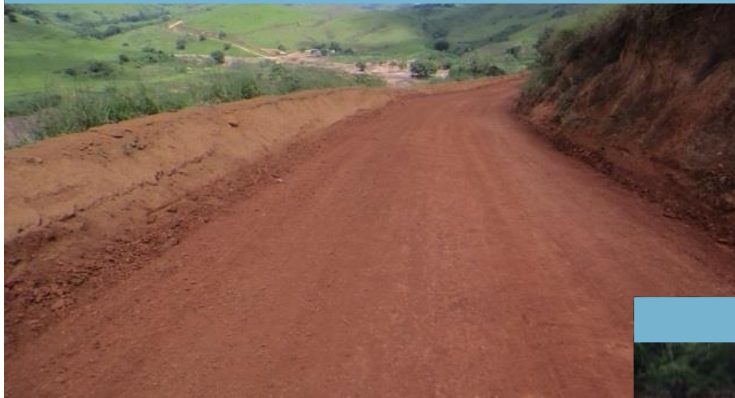
Manutenção em estradas não pavimentadas
